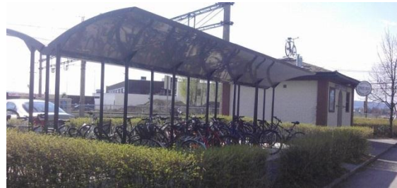
Bilde 11 Sykkelbua og sykkelparkering med takoverbygg ved Hamar skystasjon (Foto: Tor Egil Strømeng)
