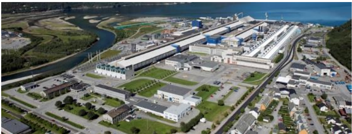
Figur 1: Hydro Aluminiums produksjonsanlegg på Sunndalsøra. De lange hallene er SU3 og SU4. Kilde: Hydro
