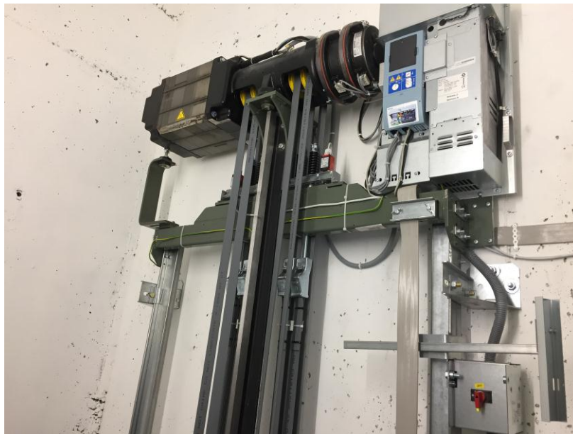
Figur 7 – Motor og drivverk på Schindler 6300
