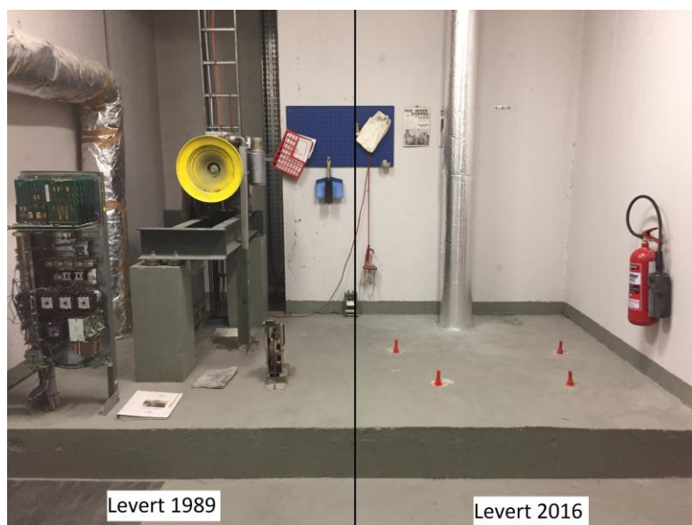
Figur 9 – Sammenligning; etasjen over sjakten 1989 og 2016
