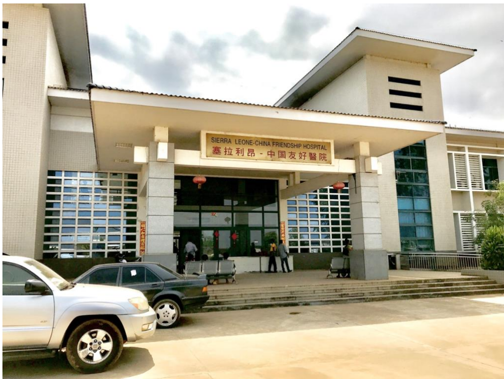
Figur 2: Sykehuset i Jui bygget ved hjelp av kineserne
