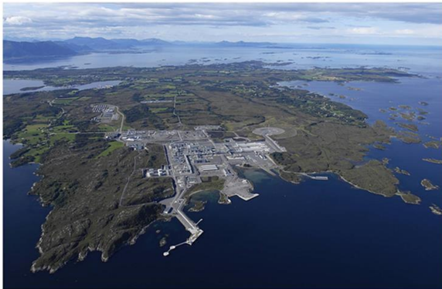
Figur 1 Oversiktsbilde over anlegget på Nyhamna
