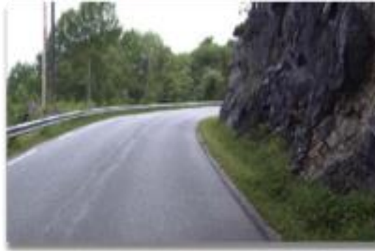
Fig. 11.0 hentet fra veg analyse fra SVV for Fylkesveg 279, Eide – Høgset for å vise vegens dårlige sikt og krappe kurvatur.
