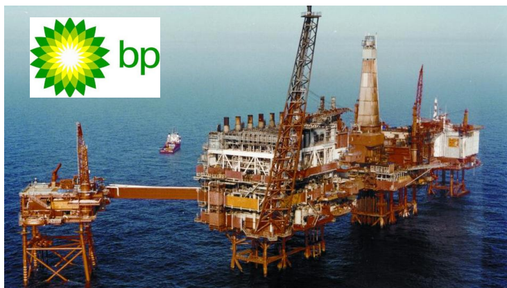
Figur 2: BP-plattformen Valhall i Nordsjøen.
