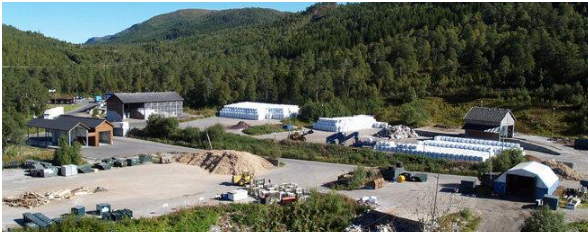
Figure 3 RIR plant in Årødalen
