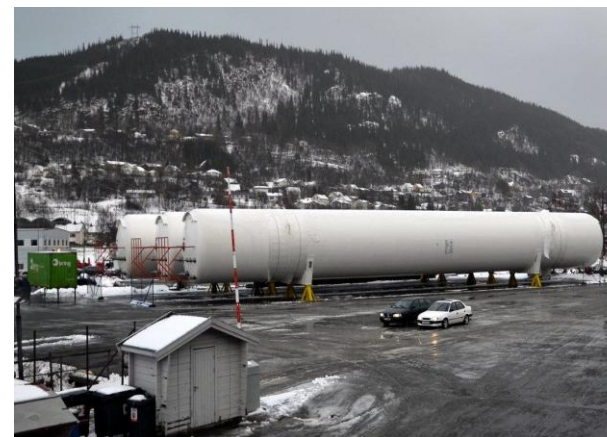
LNG Terminal in Mosjøen
