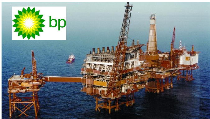
Figur 6.2: BP-plattformen Valhall i Nordsjøen.
