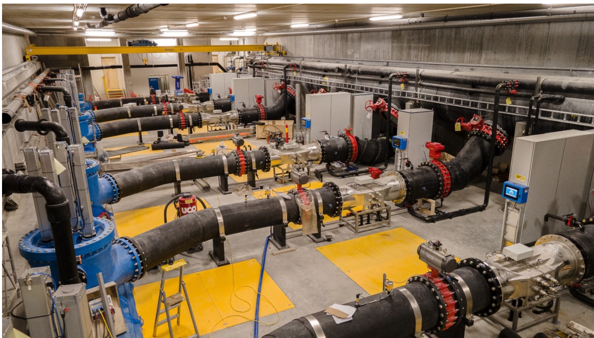
Filter i inntaksstasjon (Opphavsrett Salmon Evolution).
