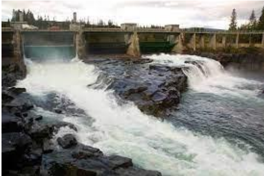
Figur 1 Kraftverk (Store Norske Leksikon)
